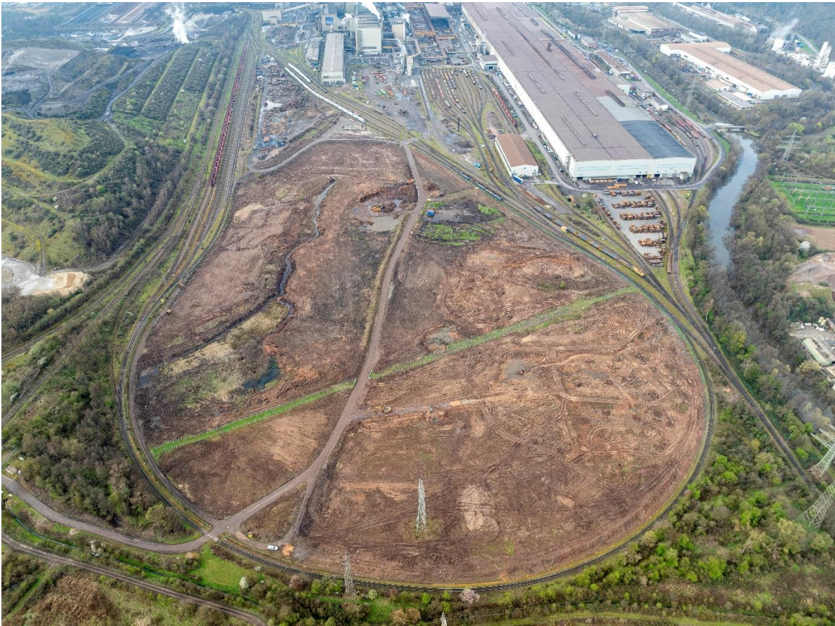
Abbildung 15: Projektgebiet nach erfolgter Waldumwandlung (Quelle: Dillinger Hütte, Aufnahme vom 18.03.2024)
