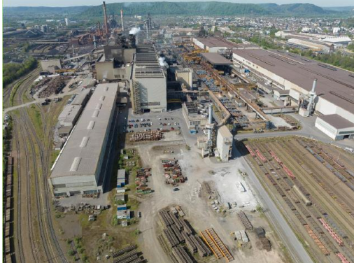
Abbildung 13: Bestandsaufnahme aus östlicher Richtung (Quelle: Dillinger Hütte)
