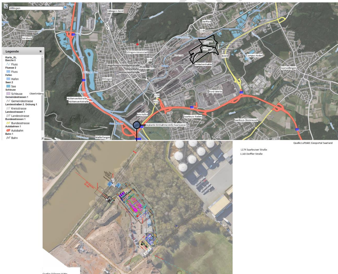
Abbildung 10: Infrastrukturelle Anbindung des Projektgebietes (Luftbild: Geoportal Saarland; Dillinger Hütte)
