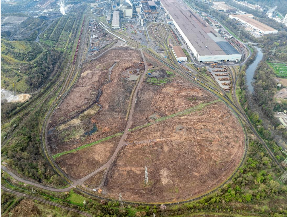
Abbildung 2: Projektgebiet nach erfolgter Waldumwandlung (Quelle: Dillinger Hütte, Aufnahme vom 18.03.2024)
