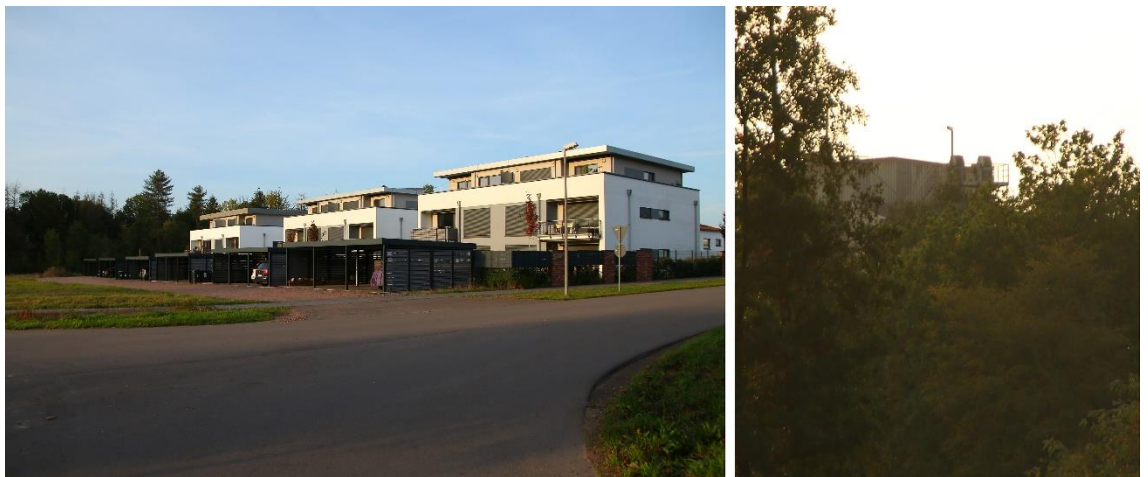
Abbildung 5. Immissionsort IO 3: Wohngebäude in der Max-Planck-Straße am Campus Nobel (links). Hinter den Bäumen ist ein Industriegebäude sichtbar, das der Firma Sakret zugeordnet werden kann (rechts).
