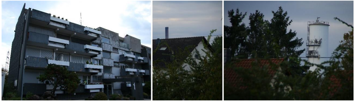
Abbildung 4. Immissionsort IO 2: Mehrstöckiges Wohnhaus in der Primsstraße 1 (links). Vom Parkplatz vor dem Wohnhaus sind Teile der Hütte einsehbar (Mitte und rechts).
