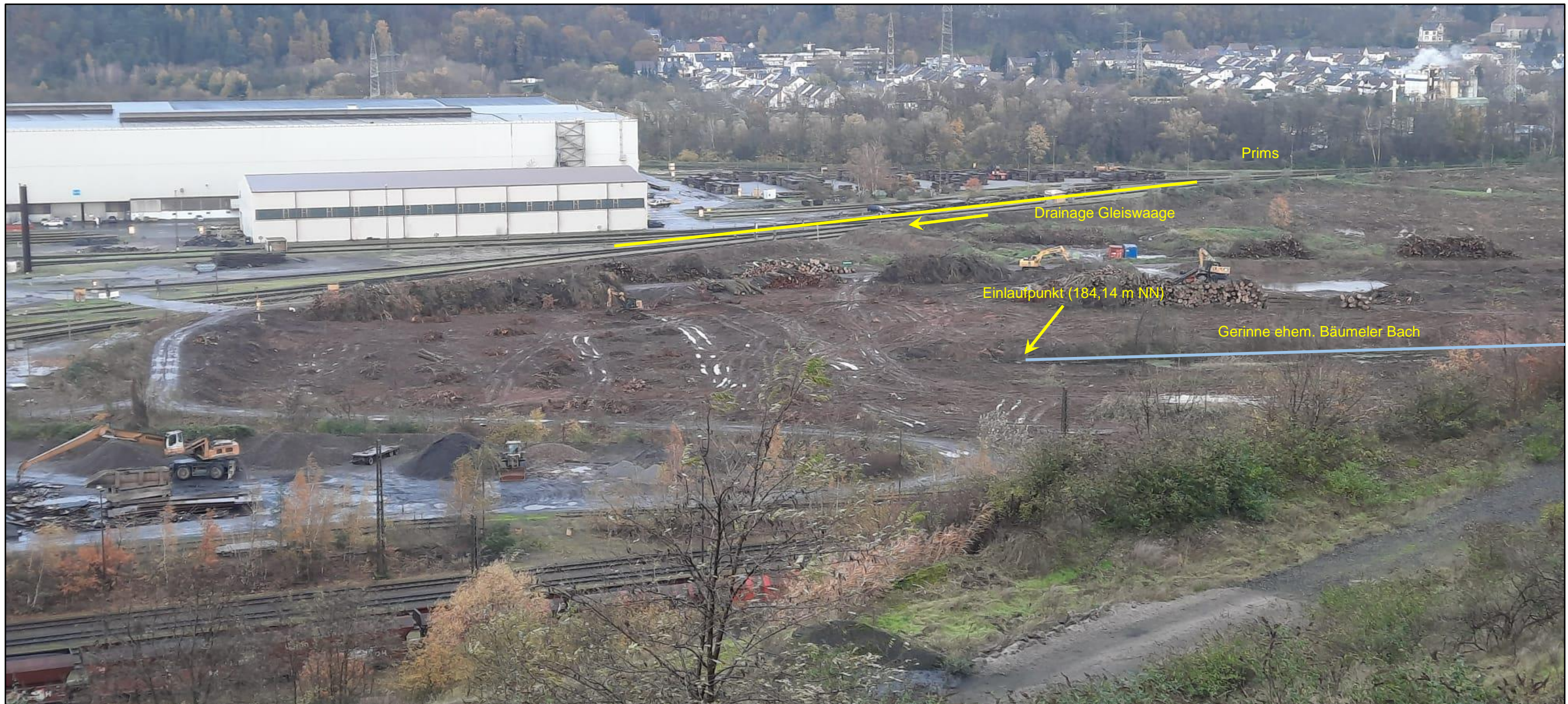
Abb. 25: Überblick über den westlichen Teil der gerodeten Projektfläche. Blick in nördliche Richtung. Markiert ist der Verlauf der Drainage Gleiswaage mit der Gefällrichtung sowie den Einlaufpunkt des ehemaligen Bäumeler Baches (Ableitung in nördliche Richtung). Keine Maßstabsangabe. Quelle: Dillinger Hütte
